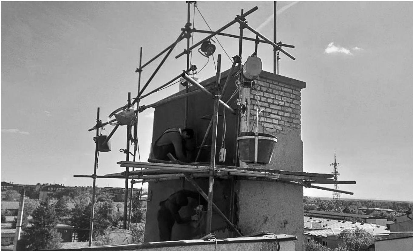
Димњак у блоку Васиља Копривице представља је претњу за станаре зграде и пролазнике због могућности урушавања малтера са фасаде и пропуштања отпадних гасова кроз пукотину на фасади и кроз димоводне канале.
